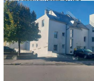
Zufahrt Tiefgarage - Anrainer
