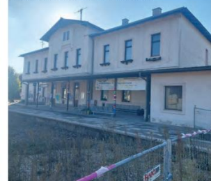
Bahnhofsbauwerk (Bestand) Nord
