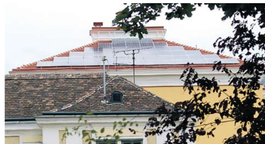
Ohne unseren Einsatz auf vielen Ebenen gäbe es weder eine PV-Anlage am Rathaus noch dessen thermische Sanierung beim Umbau
