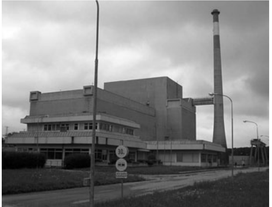
Atommeiler in Zwentendorf. Einst war er Symbol für technischen Fortschritt, dann ein Wahrzeichen für demokratische Reife und Vernunft. Und heute wächst das Gras auf den Zufahrtswegen. Doch die Atomlobby scharrt in den Startlöchern.
